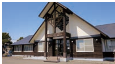
公営塾(鷗川駅近く)
